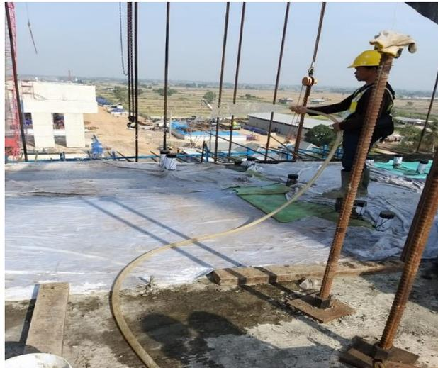
Gambar 4.45. Pekerjaan curing menggunakan *geotekstil* yang diberi air
