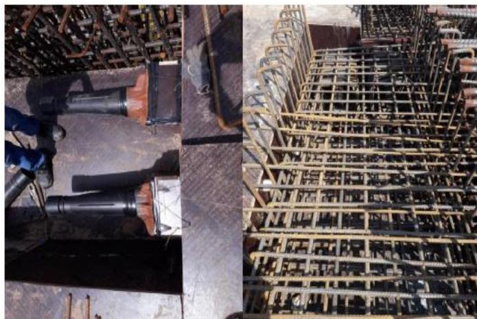
Gambar 4.42. Pemasangan ankur & pembesian blister tendon *box girder*
