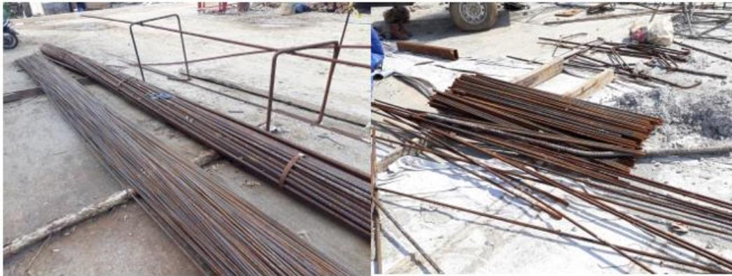
Gambar 4.7. Material tulangan ulir diameter 16 mm dan tulangan blister diameter 25 mm
