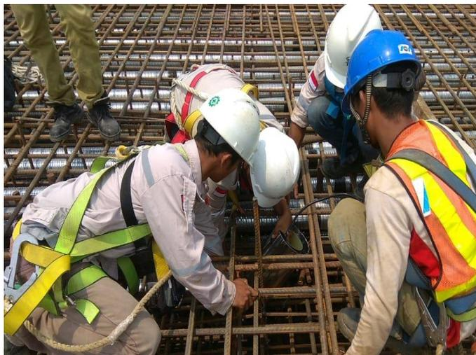
Gambar 4.40. Pemasangan duct untuk tendon *box girder*
