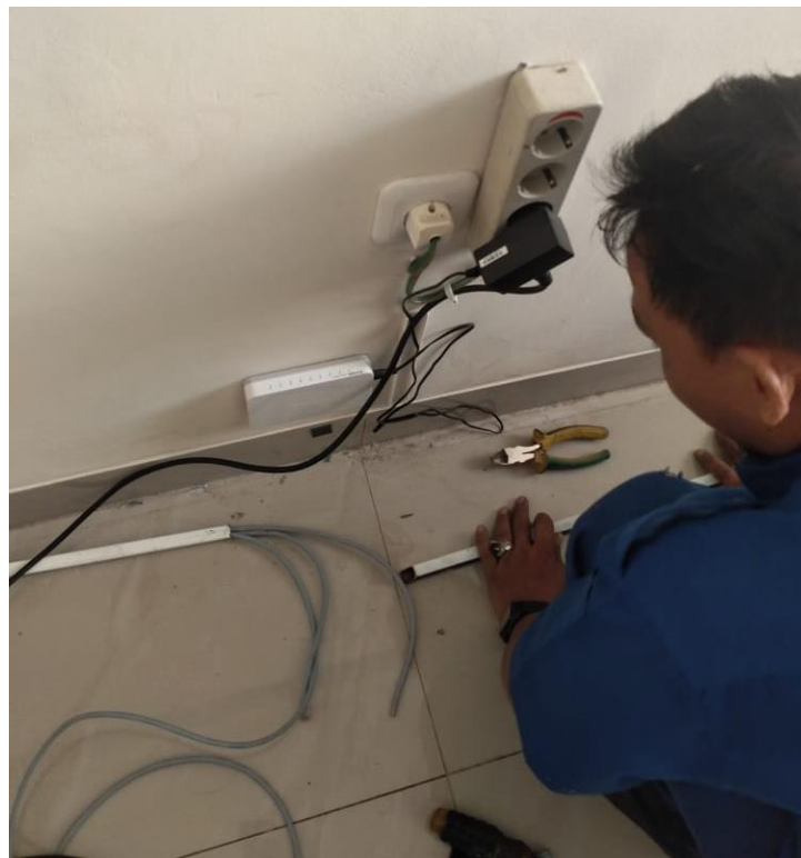
Foto saat pemasangan holo agar kabel jaringan LAN tersusun rapi
