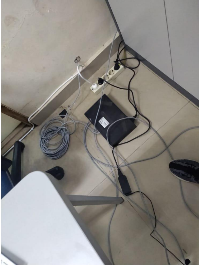
Foto kabel yang sebelum dilakukan perapian dan peremajaan
