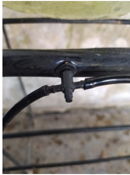
Gambar 4.2 Micro tee yang menghubungkan selang 16mm dan selang 5 mm
