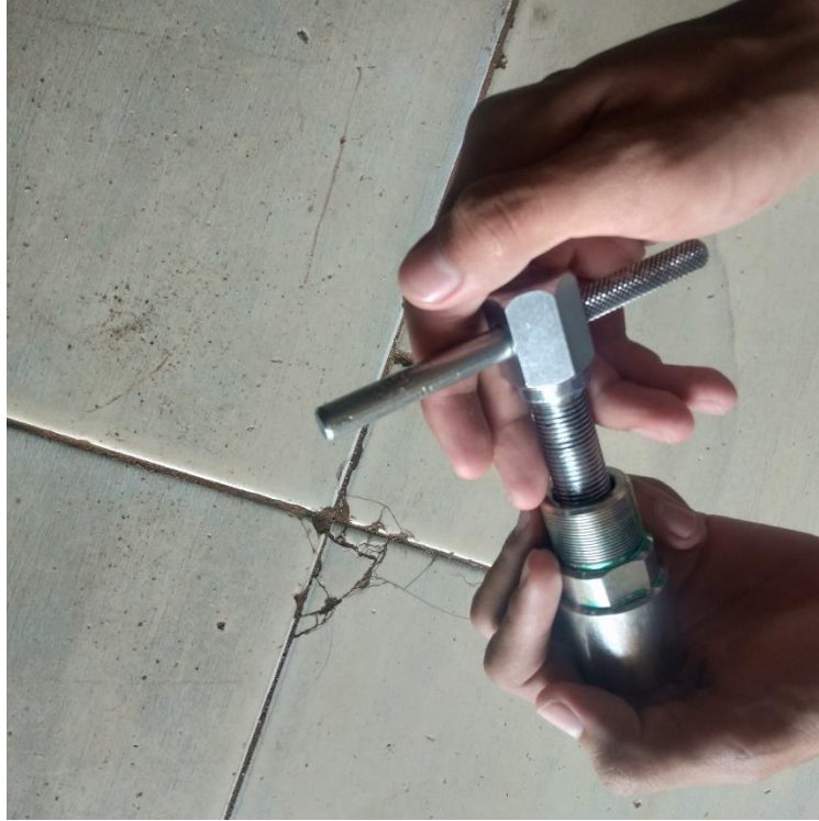
Gambar 5. Proses Pemasangan Drat Baut Ke Treker
