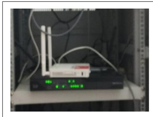
**Gambar 3.10** Router cisco dan mikrotik
