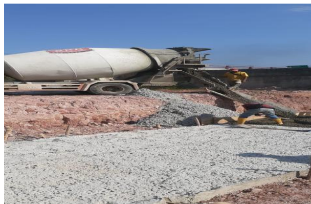
Gambar 3.12. Pengecoran lantai kerja (plat LC)
