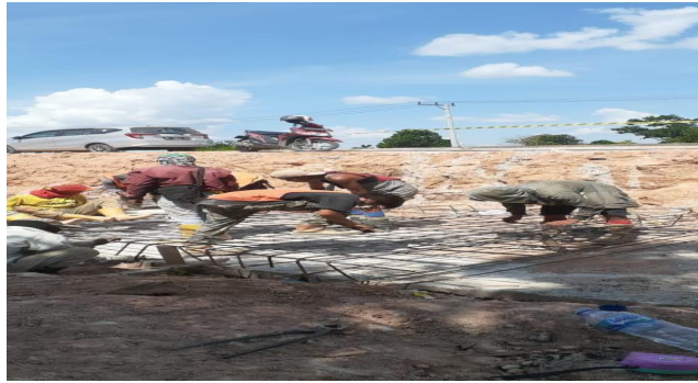
Gambar 3.13. Pembesian plat beton pondasi
