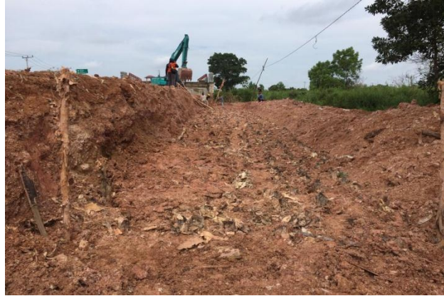
Gambar 3.11. Proses pemancangan cerucuk gelam
