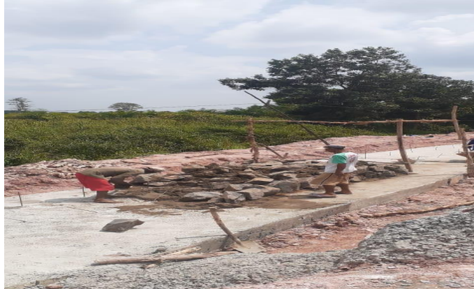
Gambar 3.14. Pekerjaan pasangan batu
