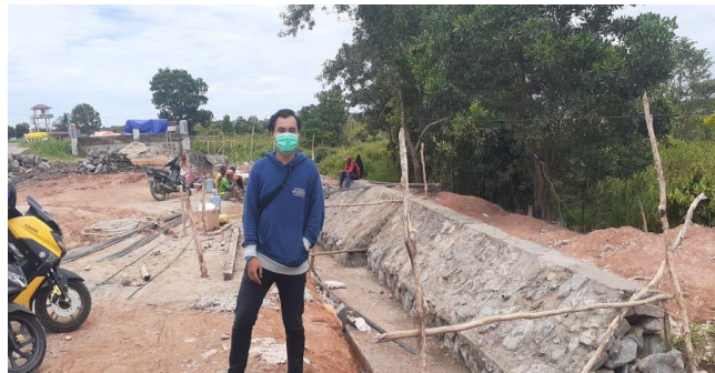
Gambar 3.15. pasangan batu yang telah di plester
