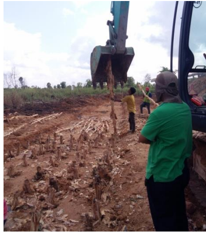
Gambar 3.13. Proses pemancangan cerucuk gelam
