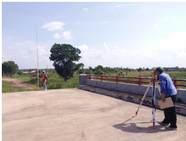
Gambar 3.10 Pengukuran Jembatan Air Tanjung B
