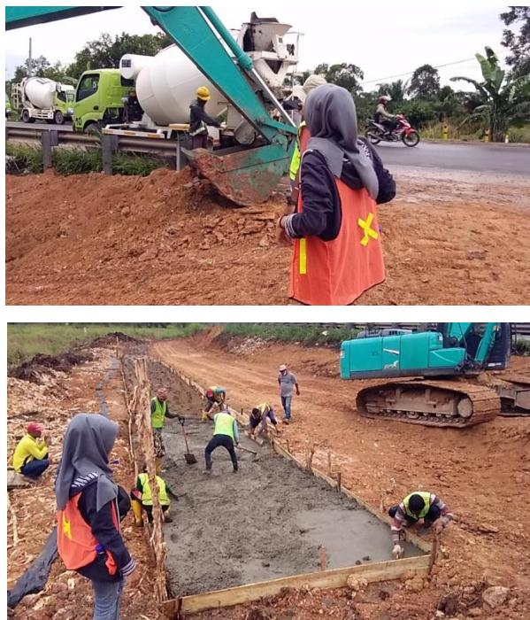
Gambar 3.14. Pengecoran lantai kerja (plat LC)
