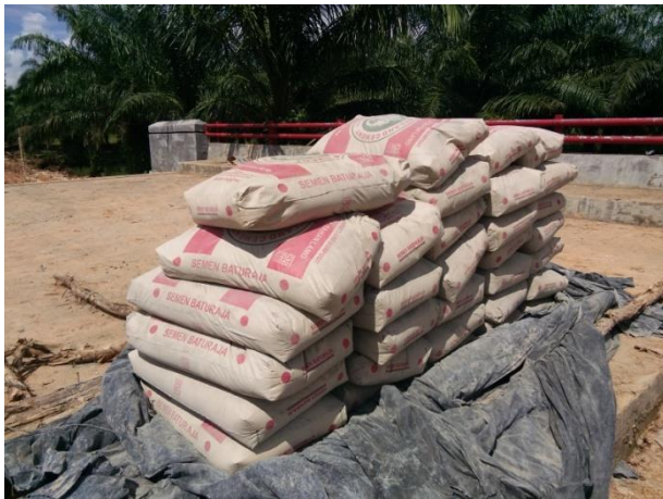
Gambar 3.11 Pengadaan bahan material ke lokasi
