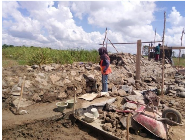
Gambar 3.16. Pekerjaan pasangan batu
