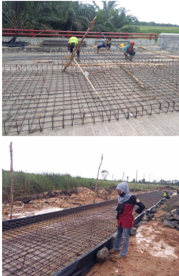
Gambar 3.15. Pembesian plat rigid
