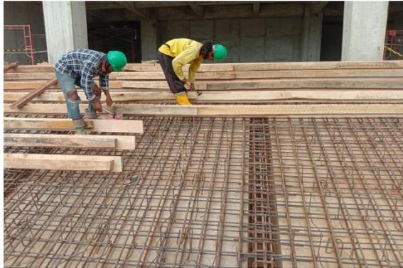
Gambar 4.8 Pemasangan Bekisting untuk Struktur Tangga
