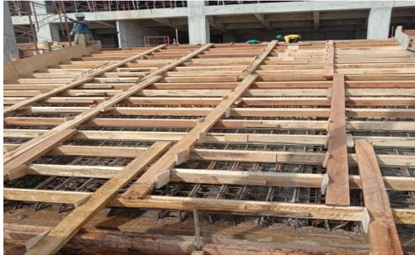
Gambar 4.10 Finishing Pemasangan Tulangan untuk Struktur Tangga
