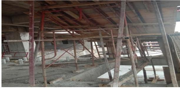
Gambar 4.7 Pemasangan *Scaffolding* untuk Struktur Tangga
