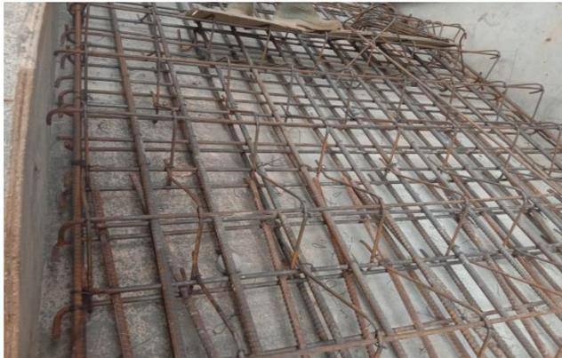
Gambar 4.9 Pemasangan Tulangan untuk Struktur Tangga
