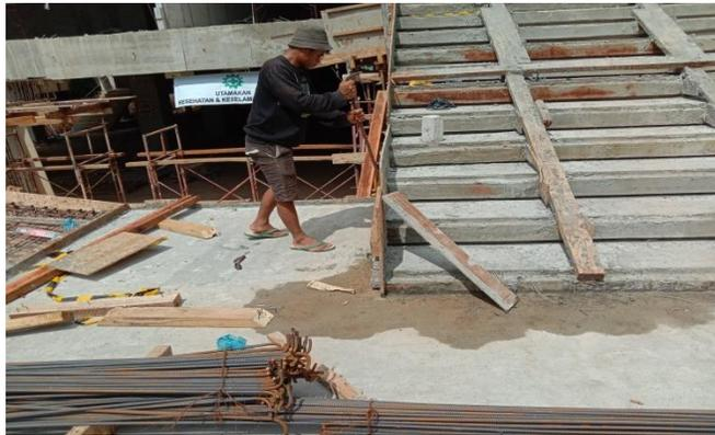
Gambar 4.12 Pelepasan Bekisting Tangga
