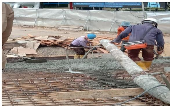
Gambar 4.11 Pengecoran Pelat lantai Tangga
