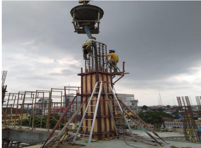
Gambar 4.11 Pengecoran Kolom menggunakan bucket
