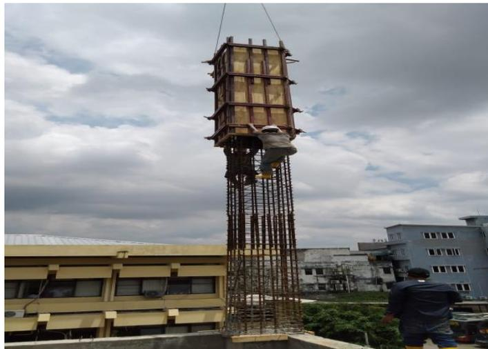
Gambar 4.10 Pemasangan bekisting kolom dengan bantuan tower crane
