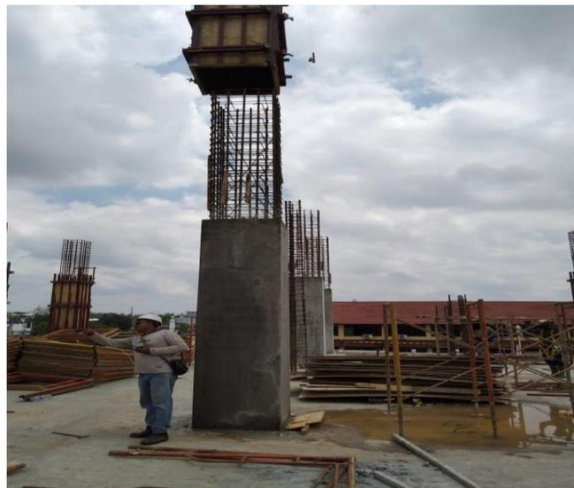
Gambar 4.12 Bekisting Kolom diangkat dengan bantuan Tower Crane
