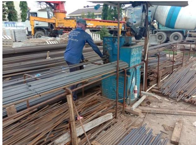
Gambar 4.7 Tempat pemotongan besi dengan bar cutter
