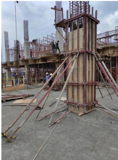
**Gambar 4.9.** Pemasangan penyangga *bekisting*
