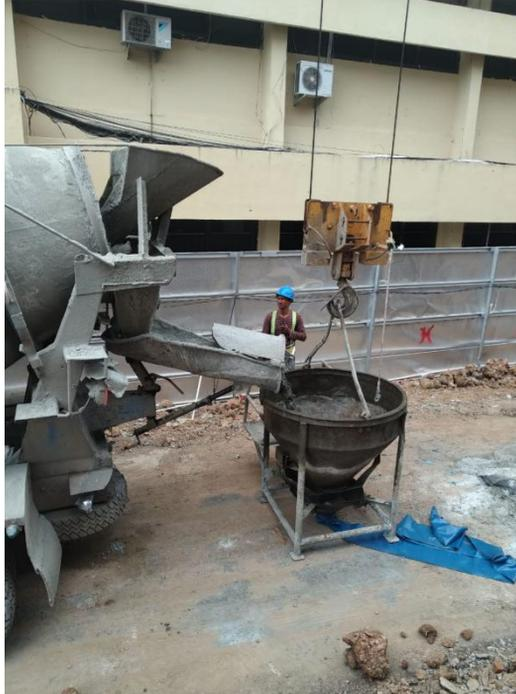
**Gambar 4.11.** Pemindahan beton *ready mix* ke *concrete bucket*
