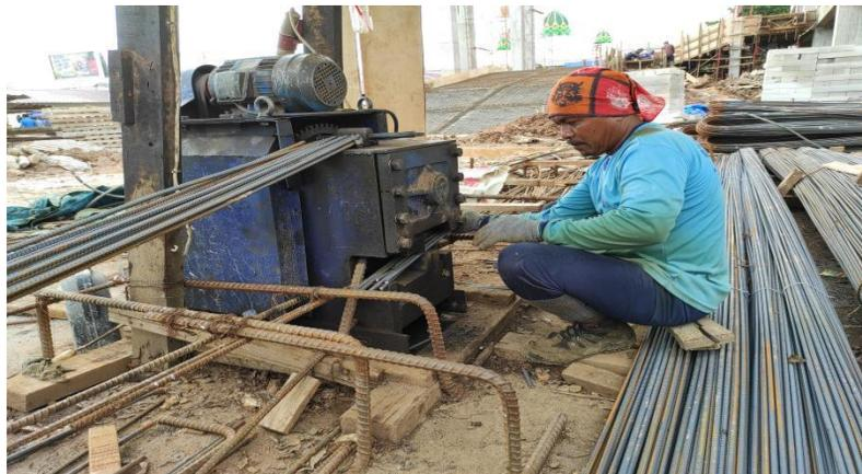
**Gambar 4.1.** Pemotongan besi tulangan
