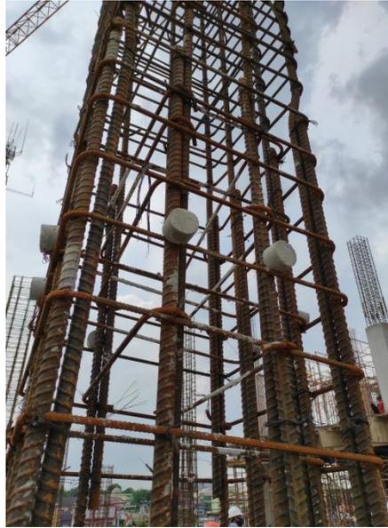
**Gambar 4.7.** Pemasangan beton decking
