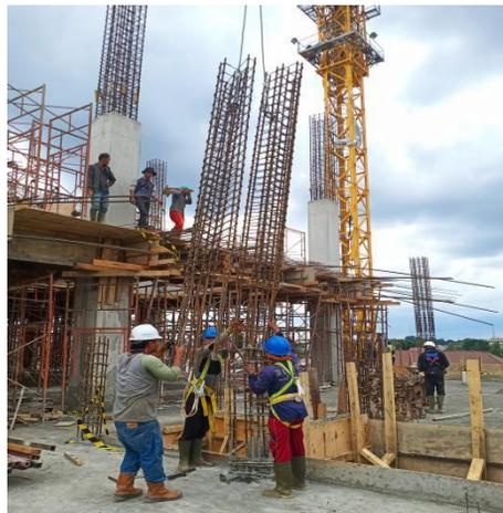
**Gambar 4.5.** Penyambungan kolom dengan bantuan *tower crane*
