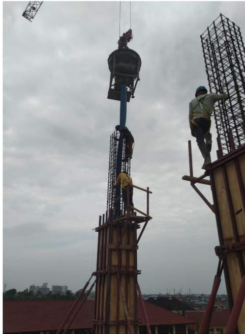
**Gambar 4.12.** Pengecoran kolom
