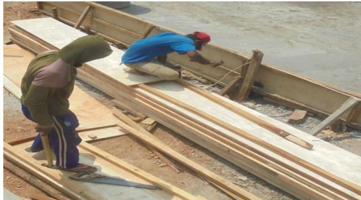
**Gambar 4.3.** Perakitan *Bekisting* Kolom
