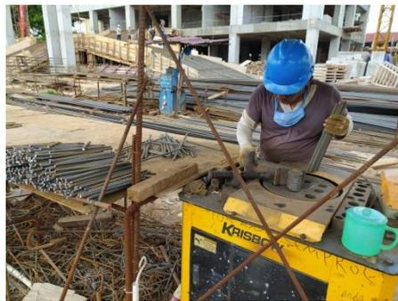
**Gambar 3.19** *Bar Bending*
