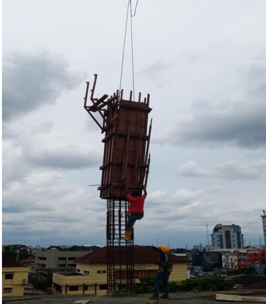
**Gambar 4.8.** Pemasangan *bekisting* kolom
