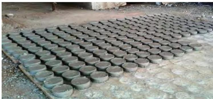
**Gambar 4.4.** Pembuatan beton decking
