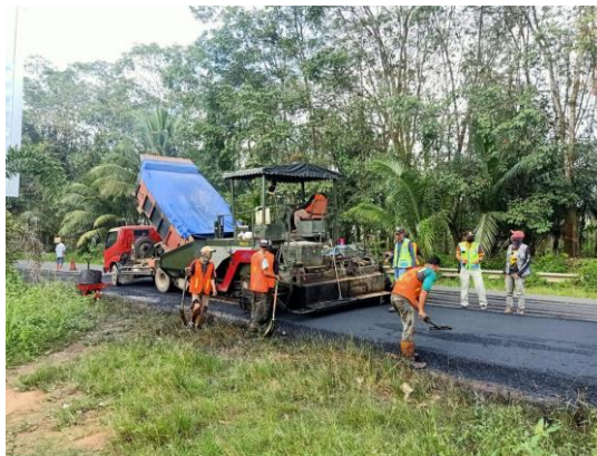
Gambar 4.1 Penggunaan Asphalt Finisher
