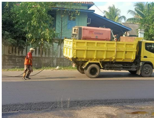
Gambar 4.5 Penggunaan Air Compressor
