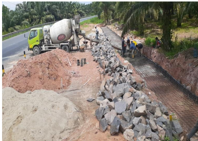
Gambar 3.2.4 bahan penyusun tembok penahan tanah
