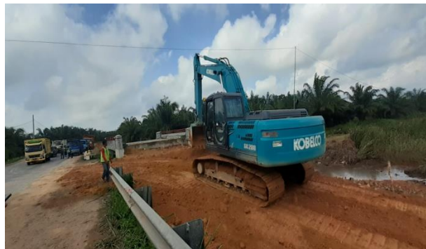
Gambar 4.3 Pekerjaan penghamparan dan pemerataan tanah biasa
