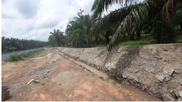
Gambar 4.9 pasangan batu yang telah di plester
