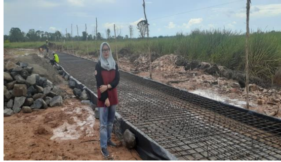
Gambar 4.6 pembesian Plat Rigid (1) dan (2)
