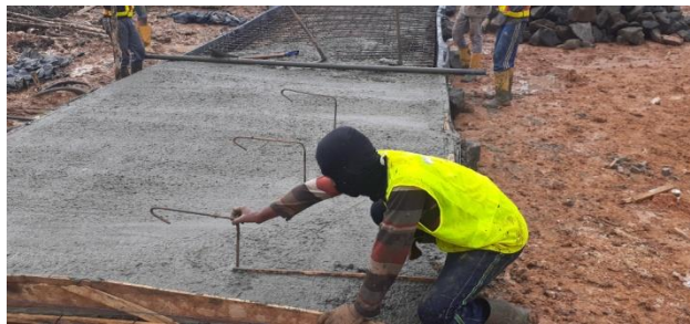
Gambar 4.7 pengecoran plat Rigid
