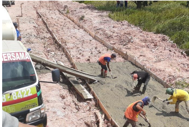
Gambar 4.5. Pengecoran lantai kerja (plat LC)
