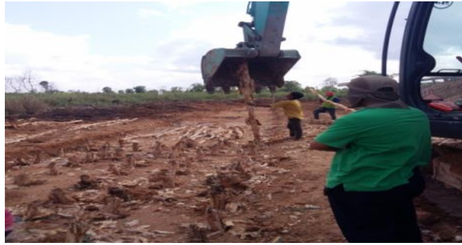
Gambar 4.4 Proses pemancangan cerucuk gelam
