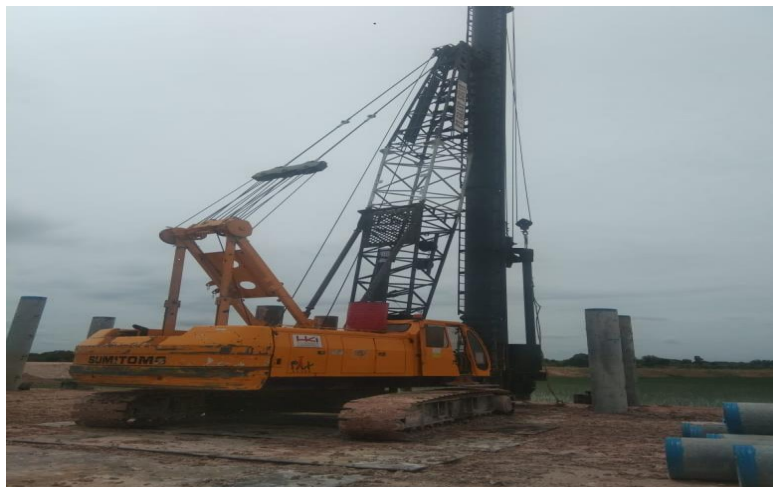
Gambar 2.7 Alat Pemancang Drop Hammer
