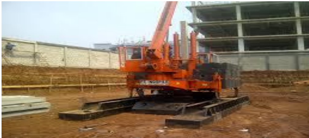
Gambar 2.6 Alat pemancang Jack in Hydraulic
