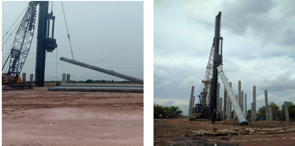
Gambar 3.11 Pengangkatan Tiang Pancang
