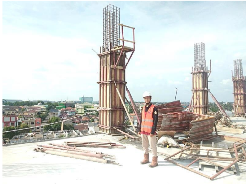
Gambar 3.6 d. Setelah pengecoran ( Sumber : Dokumen sendiri, 2020 )
