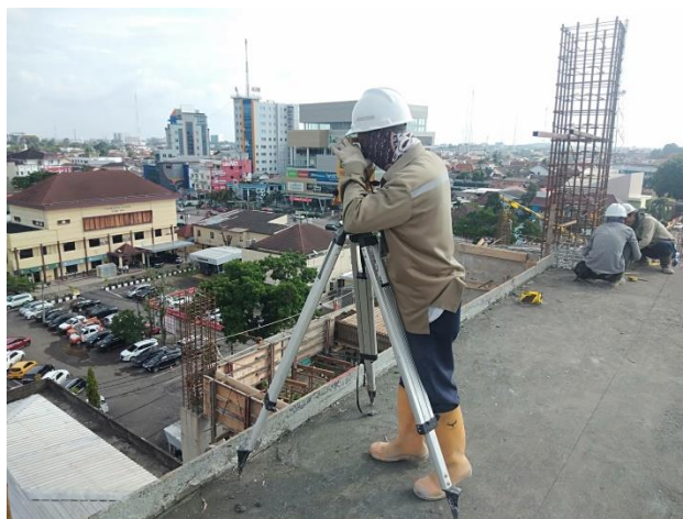
Gambar 3.2 Kegiatan penentuan as kolom menggunakan theodolite
