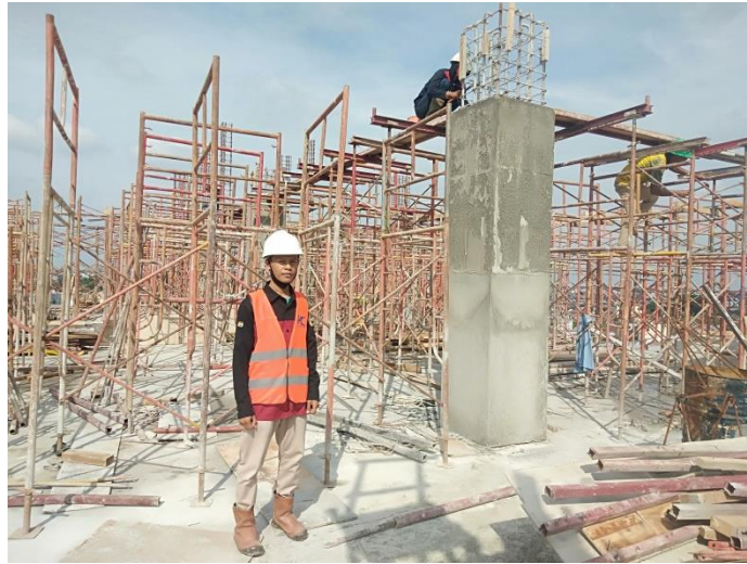
Gambar 3.7 b. Bekisting sudah dilepas ( Sumber : Dokumen sendiri, 2020 )
