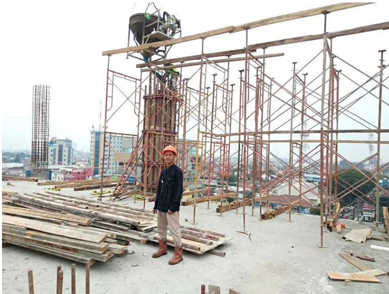
Gambar 3.6 c. Concrete bucket ( Sumber : Dokumen sendiri, 2020 )
