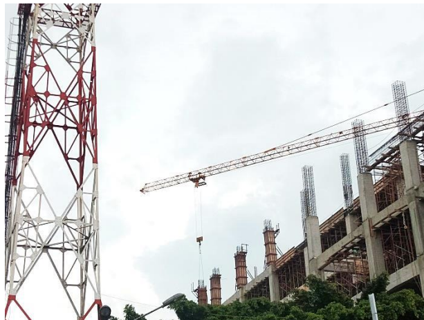
Gambar 3.5 Pemasangan bekisting dengan tower crane ( Sumber : Dokumen Pribadi, 2020 )
