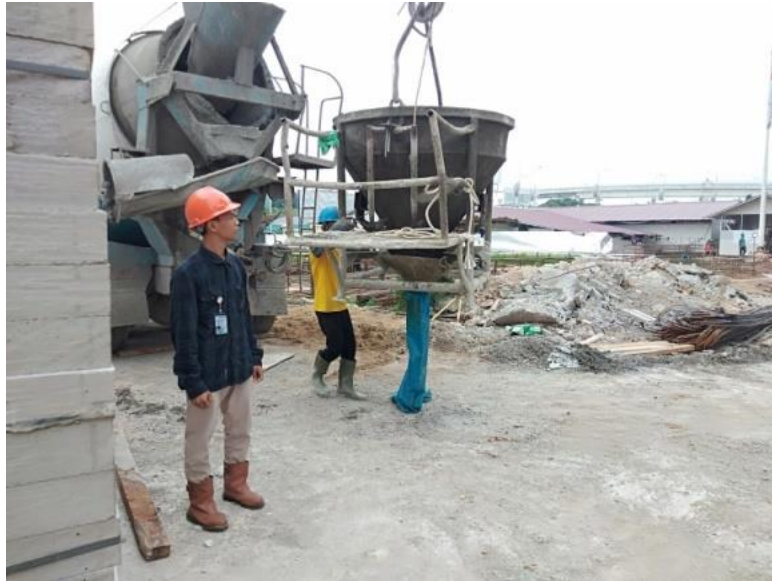
Gambar 3.6 b. Concrete mixer truck ( Sumber : Dokumen pribadi, 2020 )
