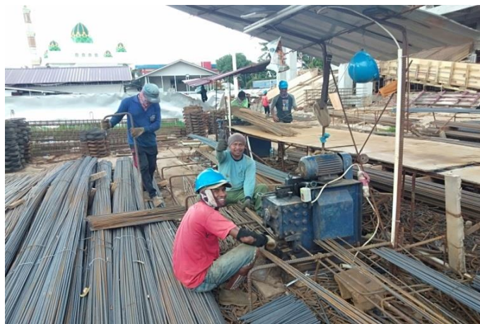
Gambar 3.3 b. Kegiatan Pemotongan Tulangan ( Sumber : Dokumen pribadi, 2020 )
