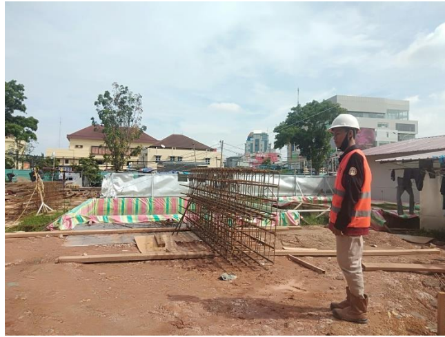
Gambar 3.4 a. Tulangan kolom ( Sumber : Dokumen Pribadi, 2020 )
