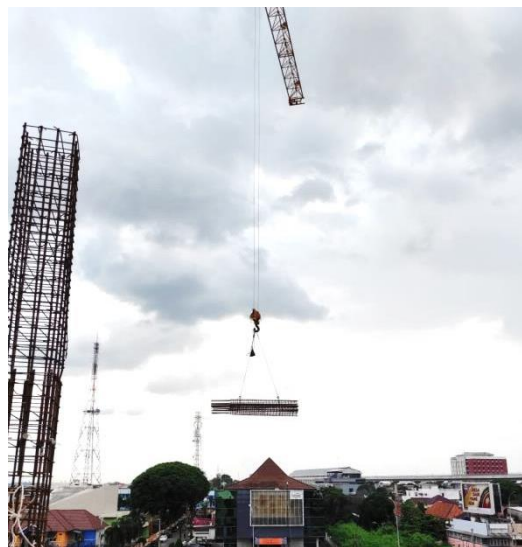
Gambar 3.4 b. Pemasangan tulangan kolom dengan tower crane ( Sumber : Dokumen Pribadi, 2020 )
