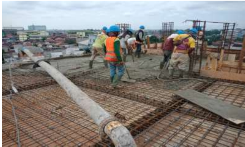
Gambar 4.5 Pengecoran Sumber: Dokumentasi Penulis, 2020
