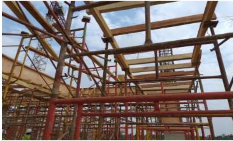
Gambar 4.1 Pemasangan Scaffolding Sumber: Dokumentasi Penulis, 2020
