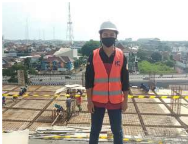
Gambar 4.4 Pemasangan Besi Sumber: Dokumentasi Penulis, 2020
