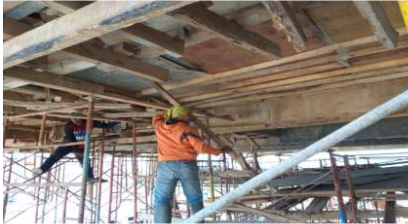
Gambar 4.6 Pembongkaran Bekisting Sumber: Dokumentasi Penulis, 2020
