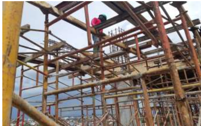
Gambar 4.2 Memasang Kayu dan Multipleks (Bekisting) Sumber: Dokumentasi Penulis, 2020
