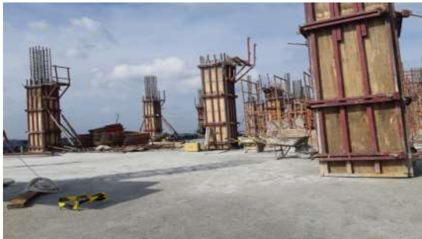
Gambar 4.6 Hasil jadi plat lantai metode konvensional
