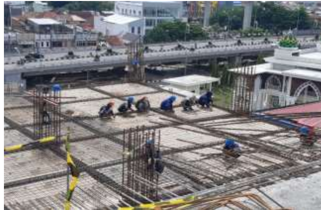
Gambar 4.3 Perangkaian Besi Sumber: Dokumentasi Penulis, 2020
