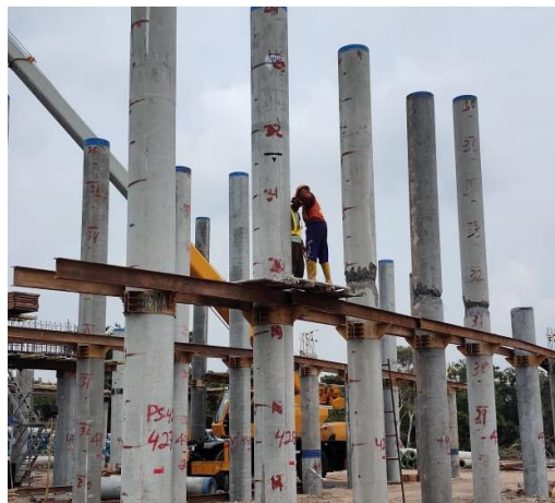
Gambar pemotongan tiang pancang
