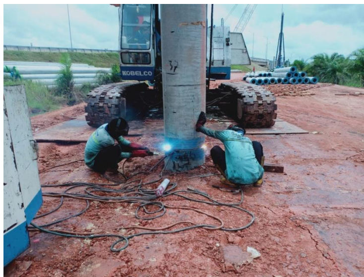
Gambar pengelasan/ join
