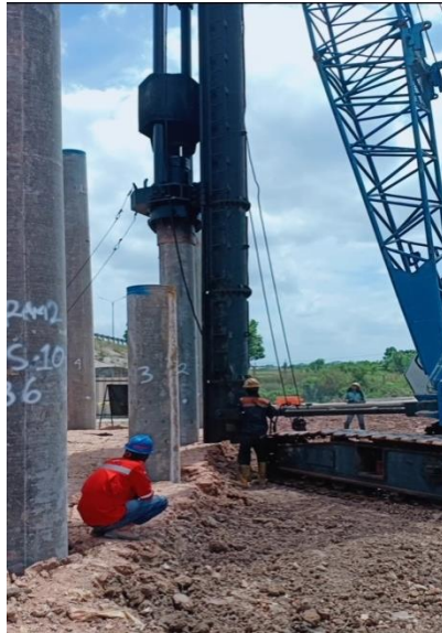
Persiapan pemukulan tiang pancang dengan drop hammer
