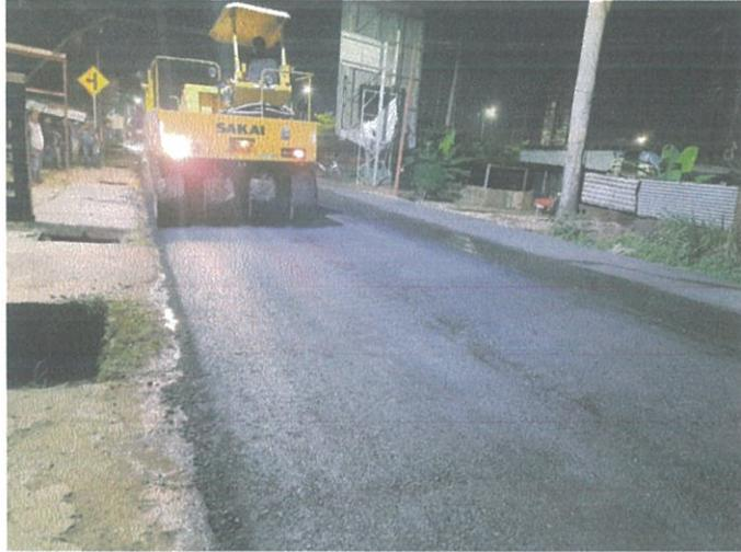
**Gambar 6. Penggilasan dengan *Tired Roller***
