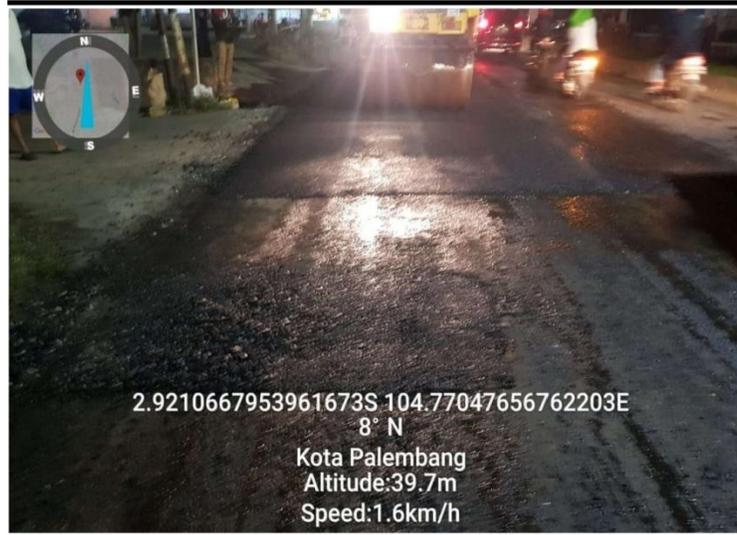
*Gambar 4.4 Pemasangan Agregat Titik Patching*
