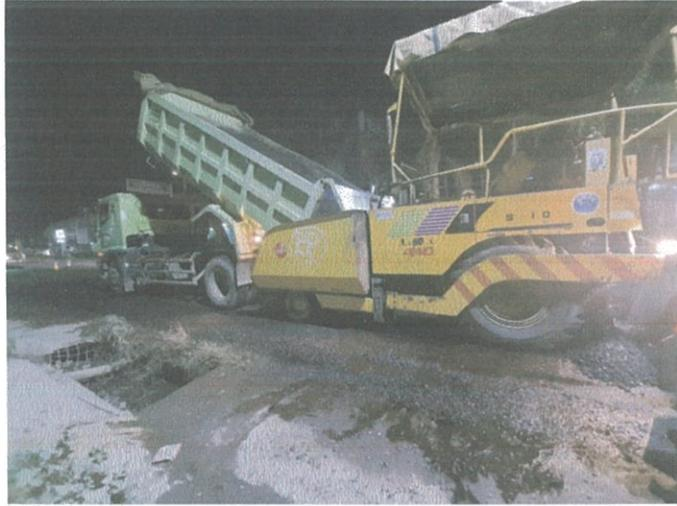
**Gambar 8.** Proses pemindahan Aspal dari *Dump Truck* ke *Asphalt Finisher*
