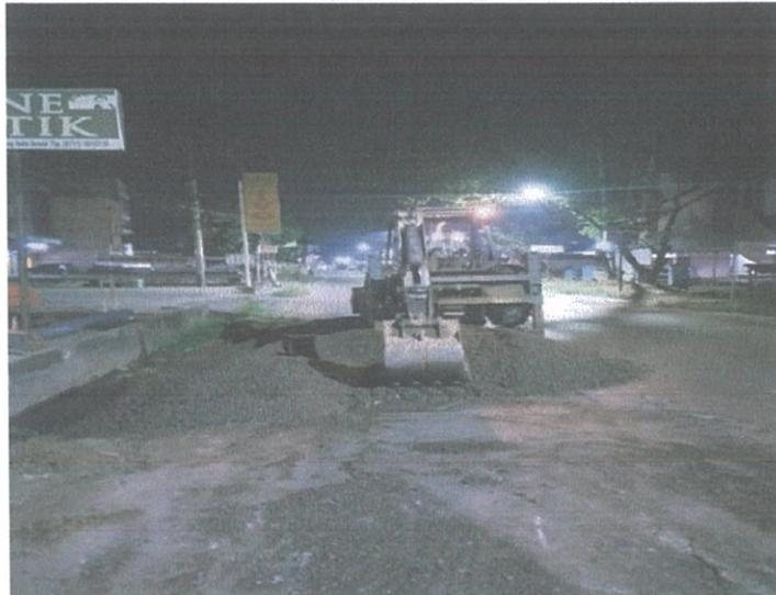
**Gambar 1. Pekerjaan *Patching* dengan Menggunakan *Backhoe Loader***
