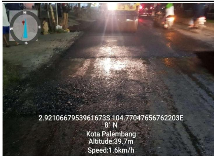
*Gambar 4.5 Pengaspalan Agregat Titik Paching*
