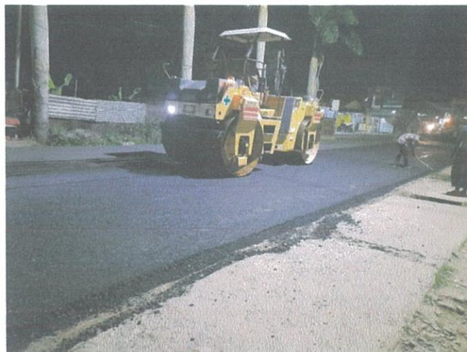
**Gambar 7. Penggilasan dengan *Tandem Roller***
