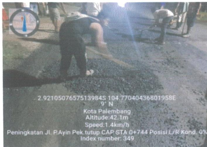
**Gambar 2. Penghampanan Agregat di Titik *Patching***
