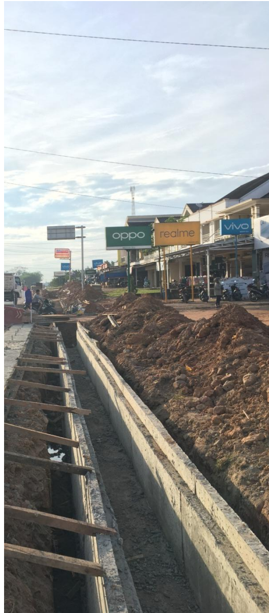
Gambar 4.4.5 Pemasangan U-ditch
