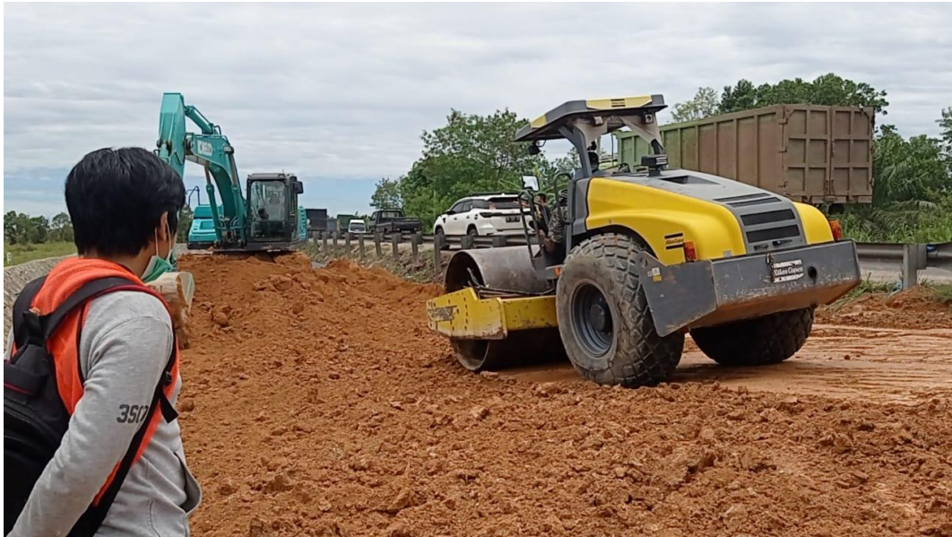
Gambar 4.4 Pemadatan Tanah Menggunakan Fibro
