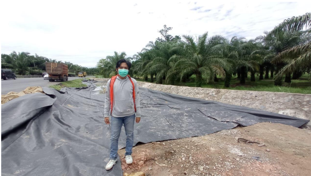
Gambar 4.2 Pemasangan Geotekstil
