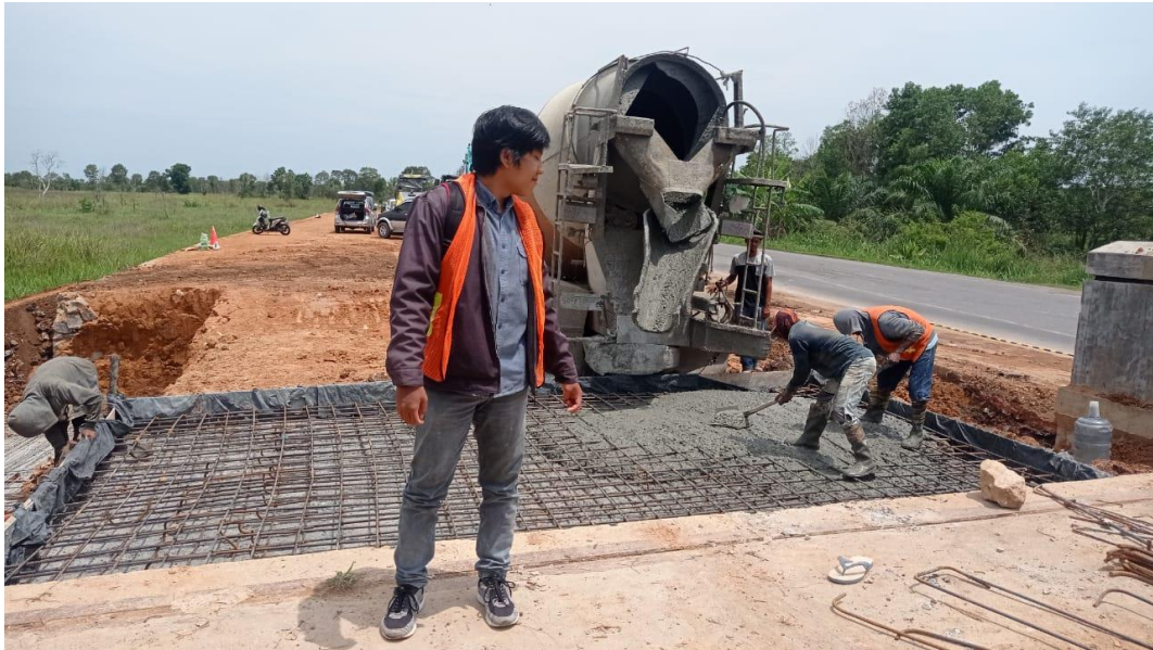
Gambar 3.5 pembesian dan pengecoran
