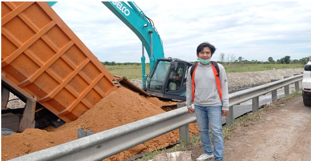
Gambar 4.3 Perletakan Material Tanah
