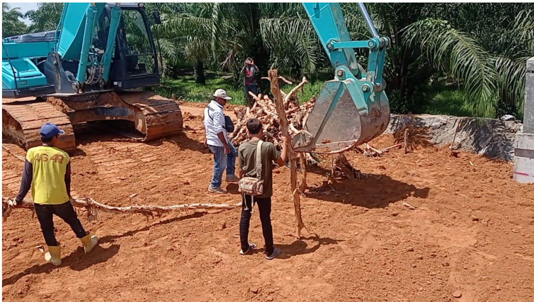
Gambar 3.3 Pemasangan cerucuk dengan kayu gelam
