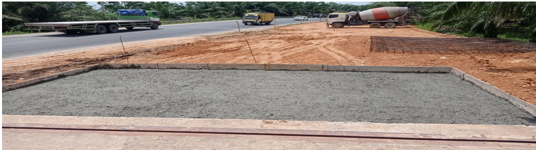
Gambar 3.4 pengecoran lantai kerja
