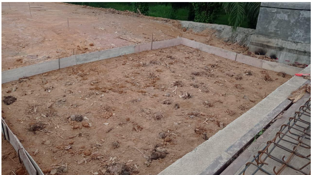
Gambar 4.16 Sebelum di Lantai Kerja
