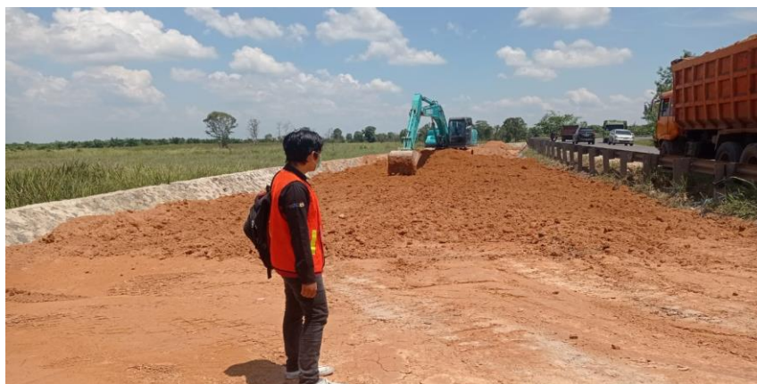
Gambar 3.2 penimbunan menggunakan tanah merah pilihan
