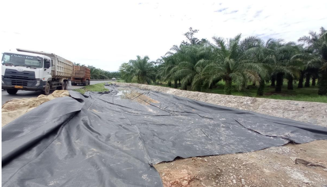
Gambar 3.1 pemasangan geotekstil
