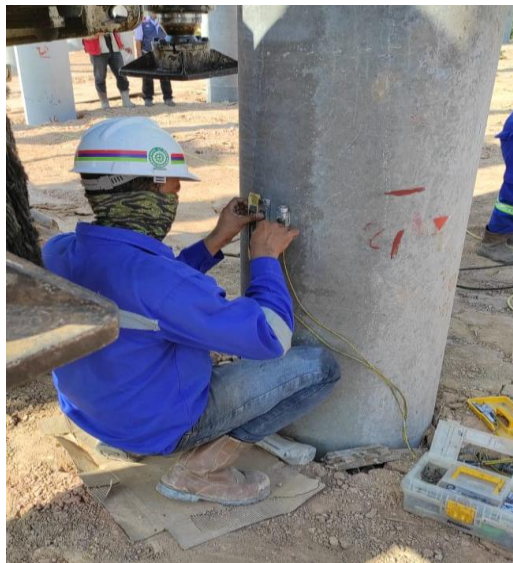
Gambar 4.9. Pemasangan Transducer dan Accelerometer
