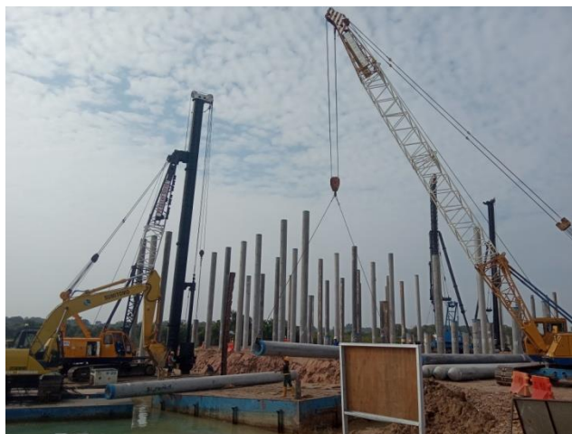
Gambar 4.2. Pemindahan Spun Pile Ke Ponton
