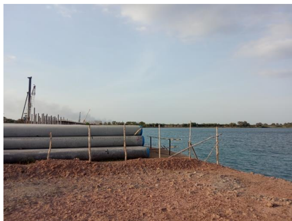
Gambar 3.2. Tiang Pancang Precast
