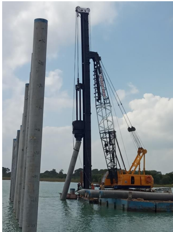
Gambar 4.3. Persiapan Crane Sebelum Memancang
