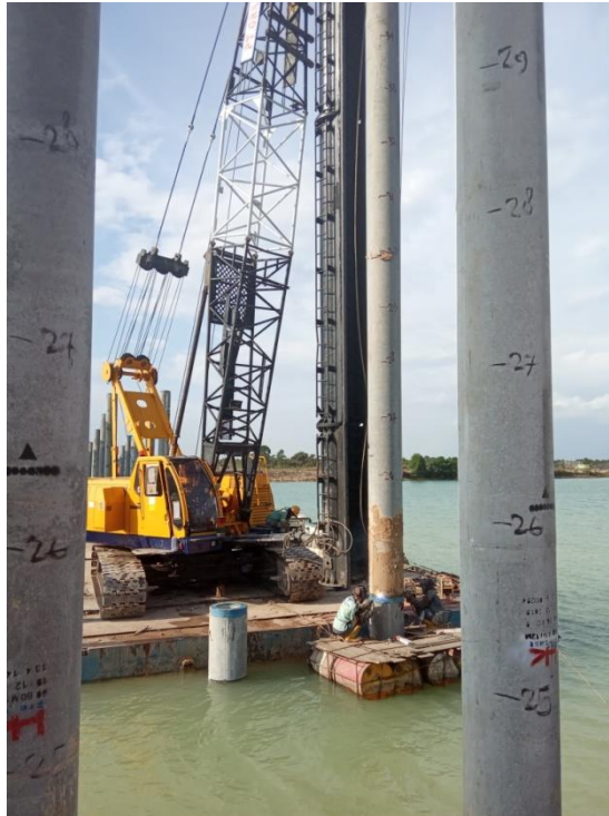
Gambar 4.5. Pengelasan Tiang Pancang
