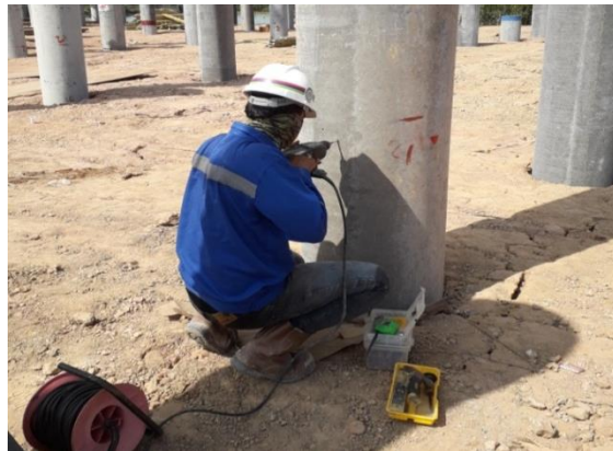
Gambar 4.8. Pengeboran Tiang Untuk PDA Test
