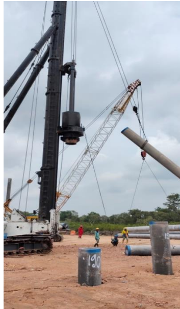
Gambar. 4.3 Pengangkatan Tiang Pancang
