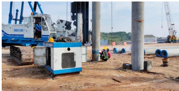
Gambar. 4.5 Penyambungan Tiang Pancang
