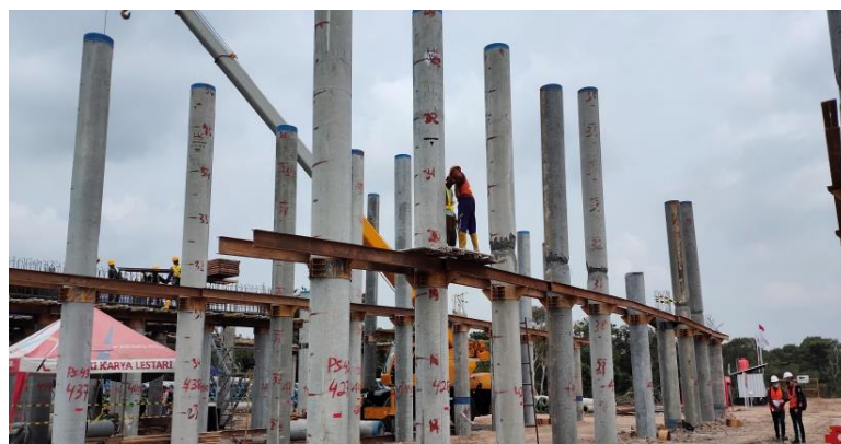
Gambar 4.7 Pemotongan Tiang Pancang
