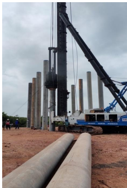
Gambar. 4.4 Pemancangan Tiang Pancang
