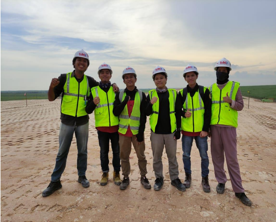
(Proyek Pembanguna Jalan Tol Ruas Indralaya – Muara Enim Seksi Simpang Indralaya Prabumulih)
