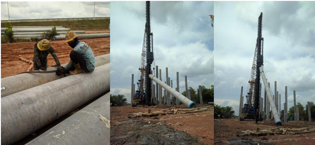
Gambar 3.13 Pengangkatan Tiang Pancang
