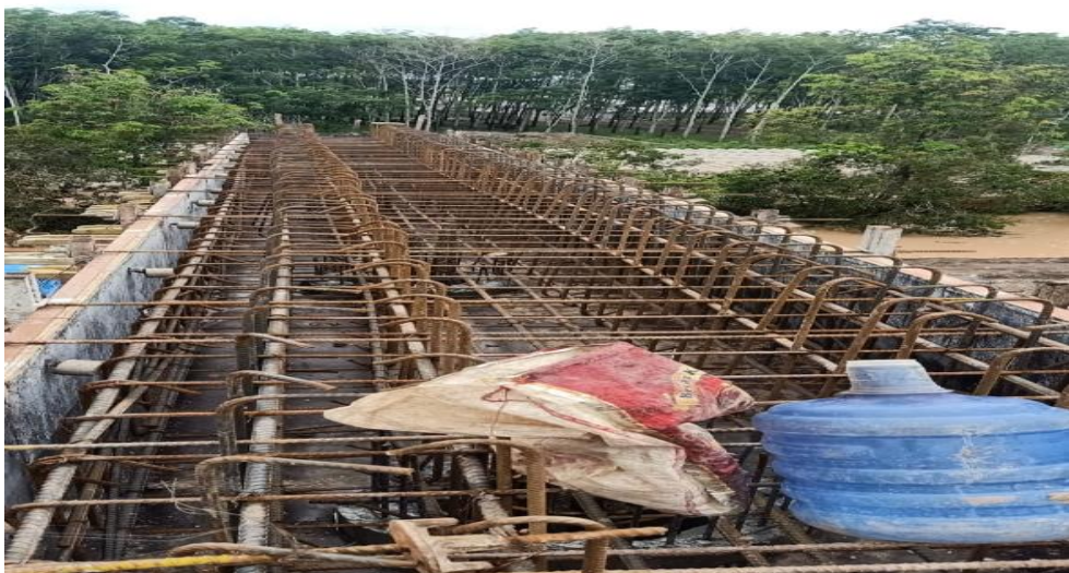
Pemasangan Rangkaian Bekisting Pile Head
