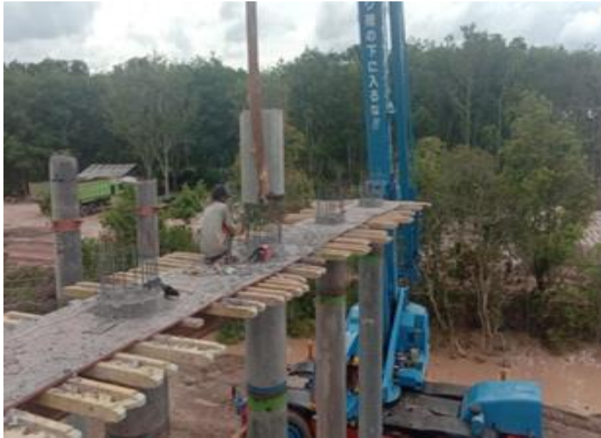
Proses Pekerjaan Cut of Pile Pondasi Tiang Panjang
