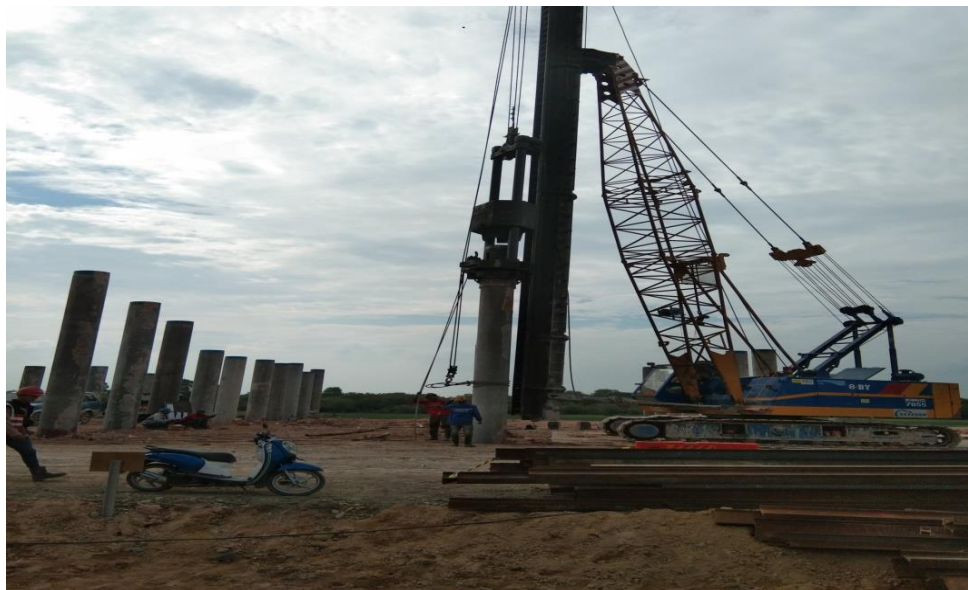
Pemasangan Pondasi Tiang Pancang
