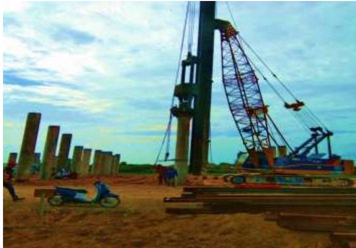
Gambar 4.1 : Pemancangan Tiang Pancang dengan Crawler Crane
