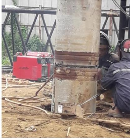
Gambar 4.20 Hasil Pengelasan Sambungan Tiang Pancang
