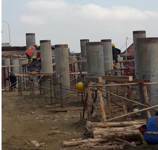
Gambar 4.22 Proses Pemotongan Tiang Pancang
