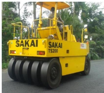
Gambar 3.11 Pekerjaan pematatan menggunakan Pneumatic Tire Roller
