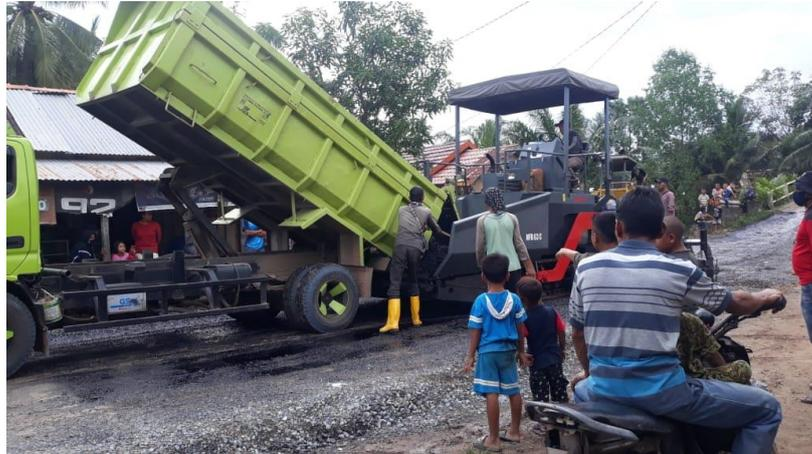
Gambar 3.8 pengangkutan aspal yang akan dimasukkan ke dalam Asphalt Finisher untuk persiapan penghamparan.
