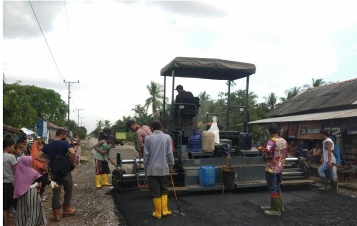
Gambar 3.9 Penghamparan dengan Asphalt Finisher.
