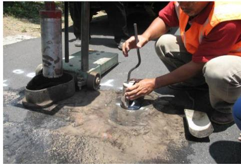
Gambar 4.4 Pekerjaan Core
