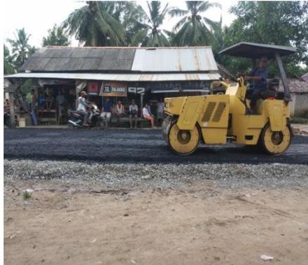
Gambar 3.10 Pekerjaan pematatan menggunakan tandem roller
