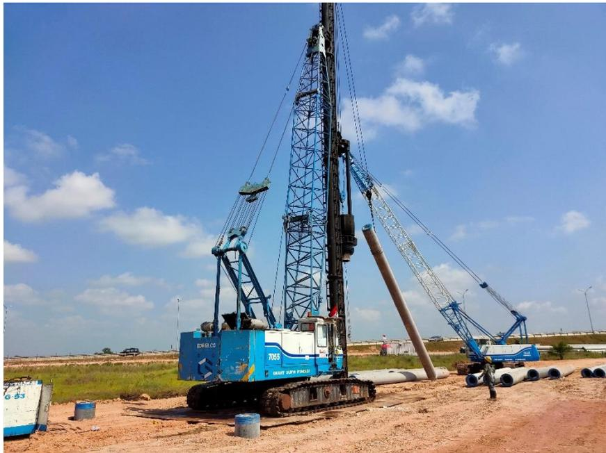
Gambar 4.7 Pengangkatan Tiang Pancang Pada Saat Pemancangan
