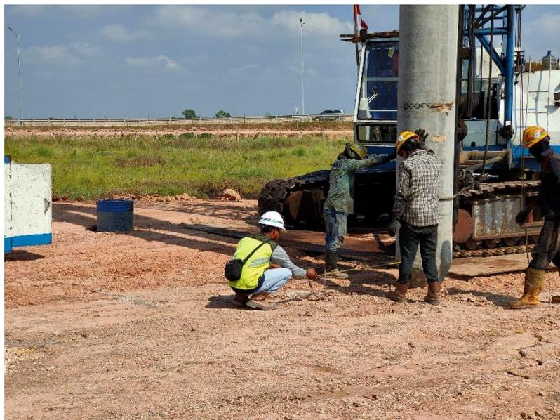
Gambar 4.6 Pengukuran Titik Tiang Pancang
