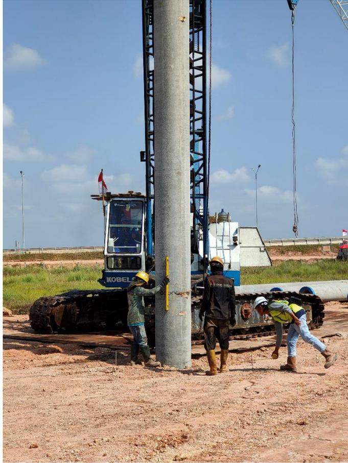
Gambar 4.8 Pengecekan Kelurusan Tiang Pancang dengan Waterpass
