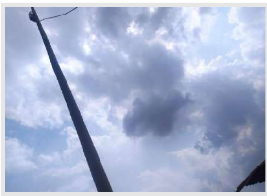
Gambar 4. Pemasangan Router Ditiang
