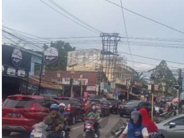
Gambar 1.1. Kondisi Eksisting Simpang 4
